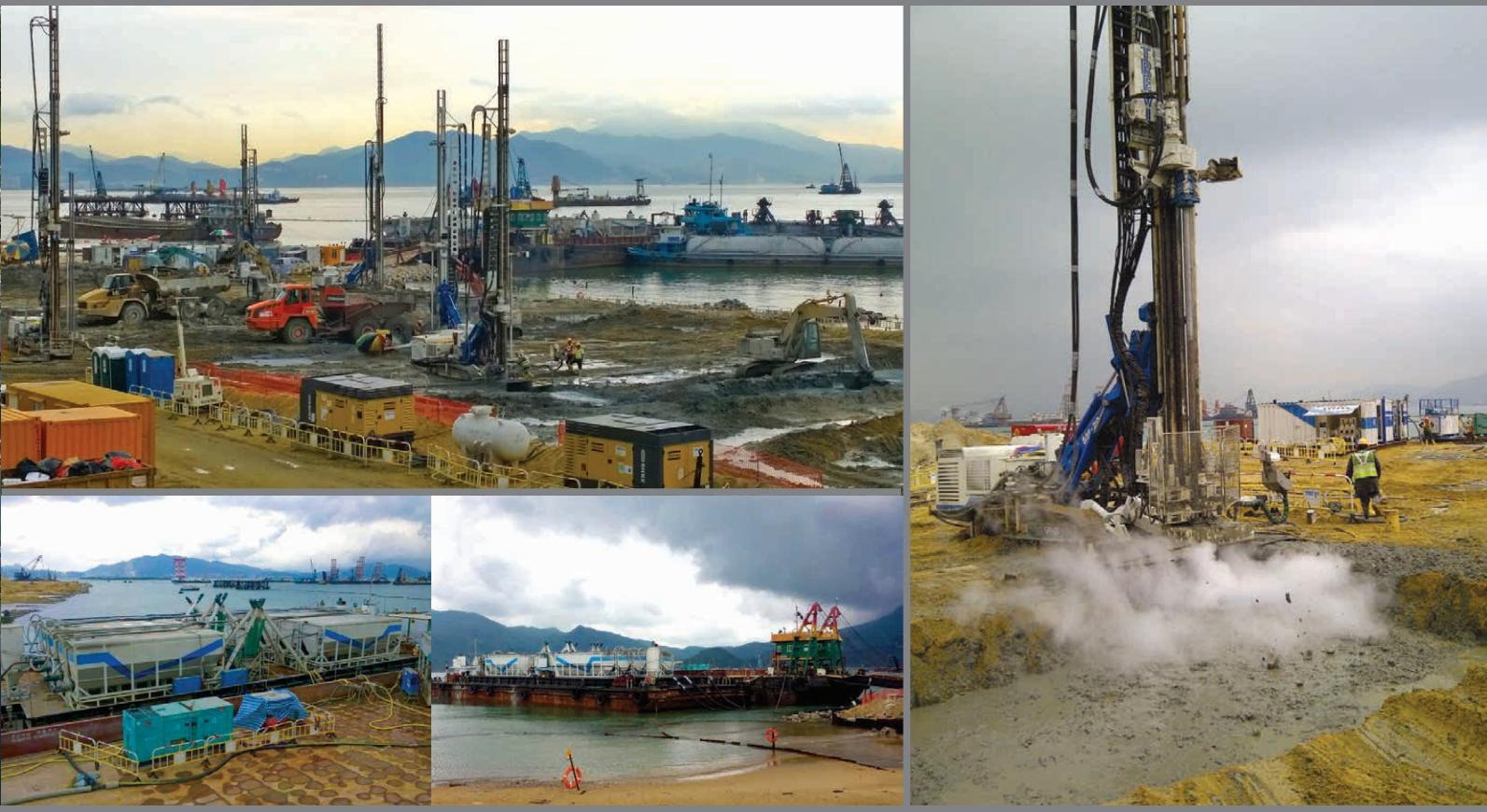
Le condizioni geologiche dell'isola artificiale hanno messo a dura prova gli sforzi di stabilizzazione. Lo strato più superficiale del terreno di circa 8,5 metri di sabbia è infatti seguito da circa 18,5 metri di fango marino molto morbido. Trevi ha dovuto effettuare una perforazione attraverso questi strati fino ad arrivare a trattare il terreno per almeno un metro nel materiale alluvionale sottostante.
